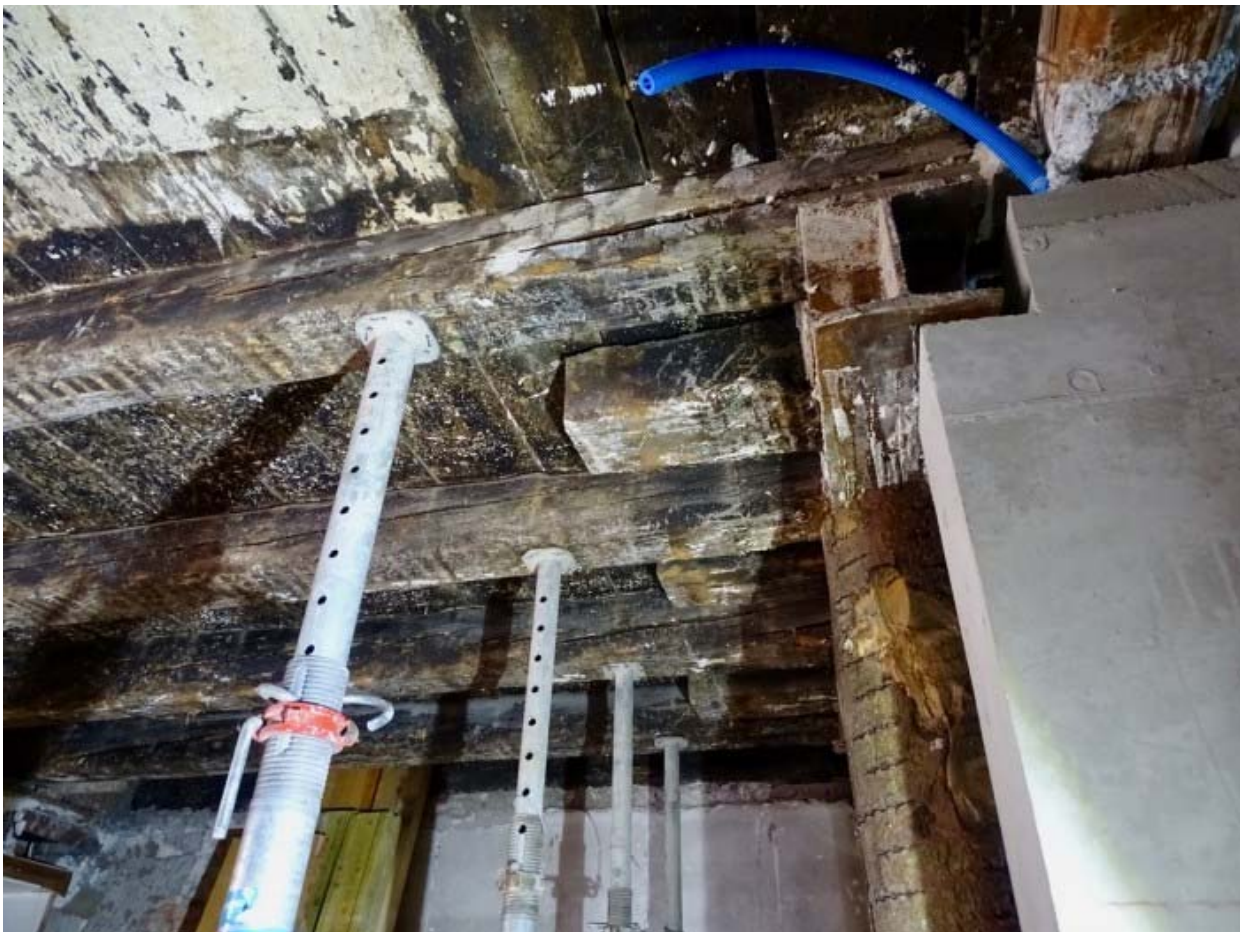
Balken aus dem 14. Jahrhundert: Sie dürfen bleiben, werden jedoch noch ordentlich geputzt. (Bild: wia)
